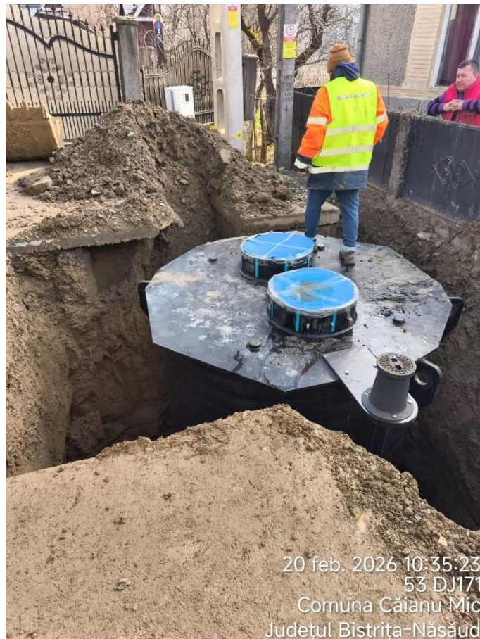
UAT Căianu Mic loc. Căianu Mic - montare SPAU
