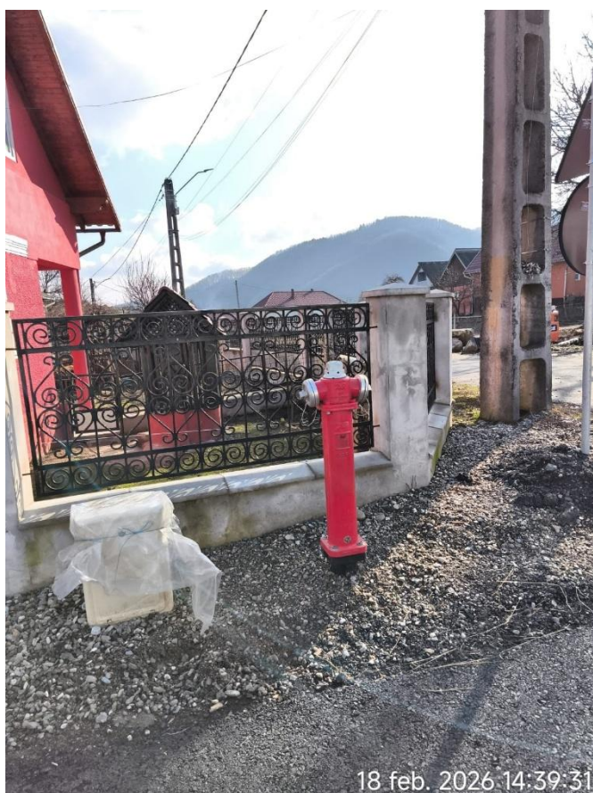
UAT Căianu Mic loc. Dobric - montat branșament apă și hidrant -
