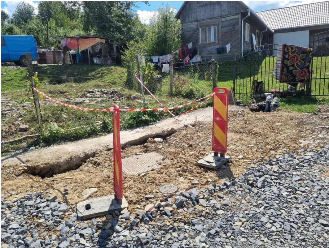
JOSENI BÂRGĂULUI – extindere apă și canalizare
