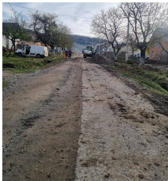
Extindere alimentare cu apă CUȘMA, com. Livezile 09.11.2023
